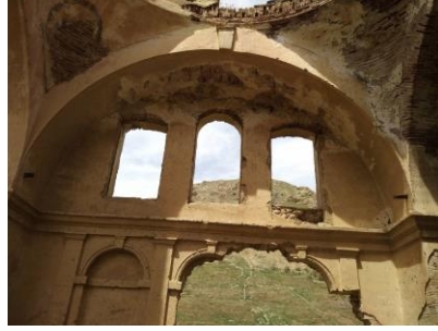
Foto:12- Kilise Kuzey İç Cephe Görünüm, 2018
