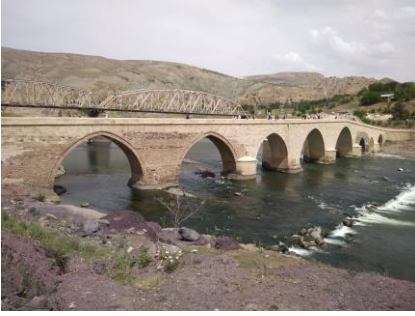
Foto:7- Palu Köprüsü 2018
