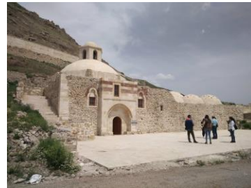
Foto:10- Palu Hamamı Restorasyondan Sonra
